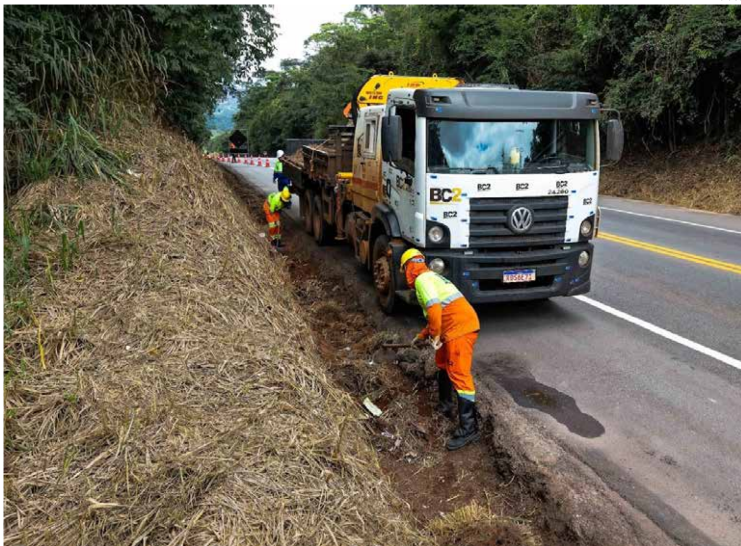
Em toda a extensão da Nova 381, a concessionária realiza outras intervenções para garantir a segurança dos usuários
